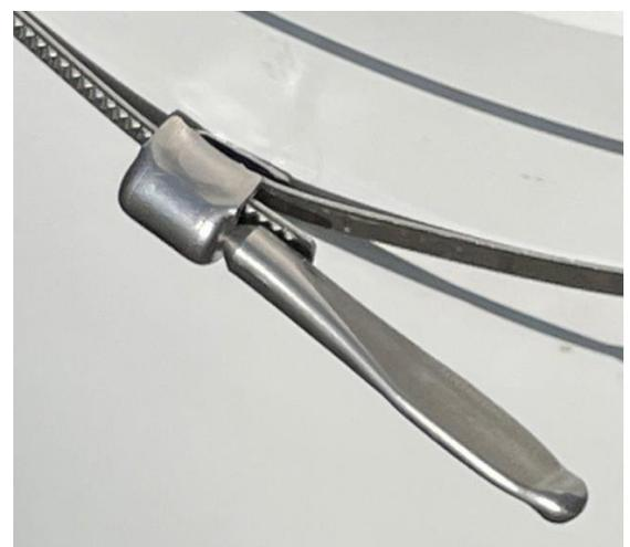
Abbildung 23: Befestigung Vogelschutzring
